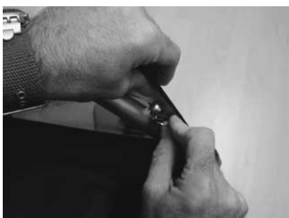
Montieren Sie das Befestigungsset wie abgebildet mit der Schraube von außen nach innen. Wiederholen Sie den Vorgang auf der anderen Seite.
